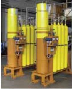
用于发电厂轴流泵润滑或涡轮安全保护的活塞蓄能器及补充气瓶站。
